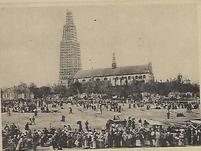
Wieża w czasie budowy
